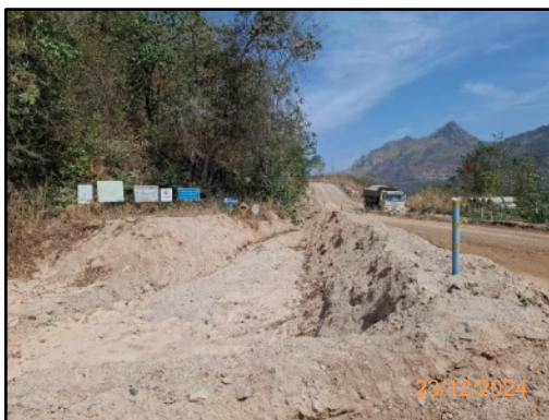
จ. ลักษณะคูระบายน้ำภายในพื้นที่โครงการ
